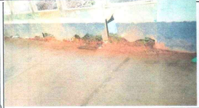
Reparacion de paredes de aulas
