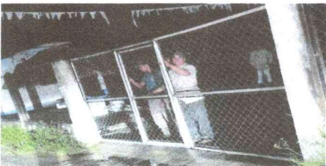
Foto 17: PUESTA DE PORTÓN PRINCIPAL Y SECUNDARIO
