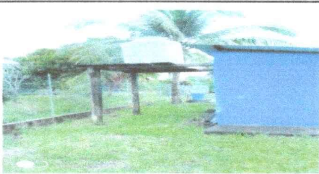
Foto 15: SUSTITUCIÓN DE DEPOSITO DE AGUA 1100 LT E INSTALACIÓN
