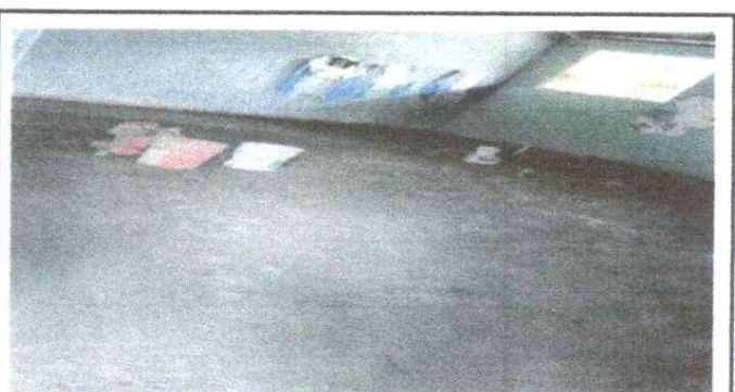
Foto 10: SUSTITUCIÓN DE PISO DE TORTA DE CONCRETO
