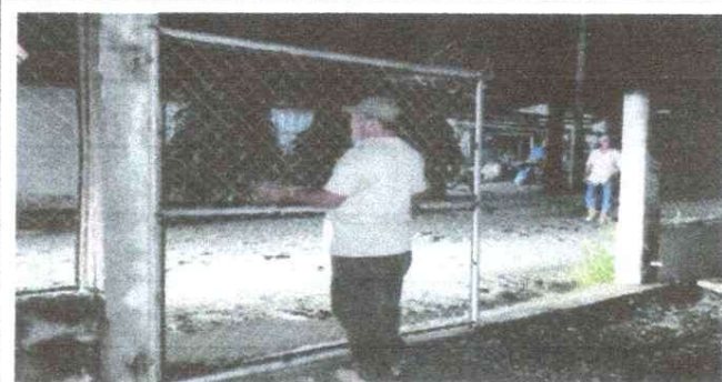
Foto 11: PUESTA DE PORTÓN PRINCIPAL Y SECUNDARIO
