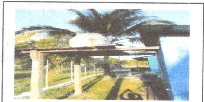
Foto 3: SUSTITUCIÓN DE DEPOSITO DE AGUA 1100 LT E INSTALACIÓN
