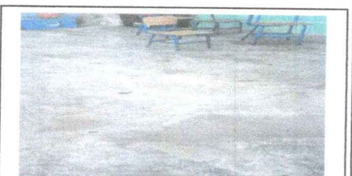
Foto 4: SUSTITUCIÓN DE PISO DE TORTA DE CONCRETO
