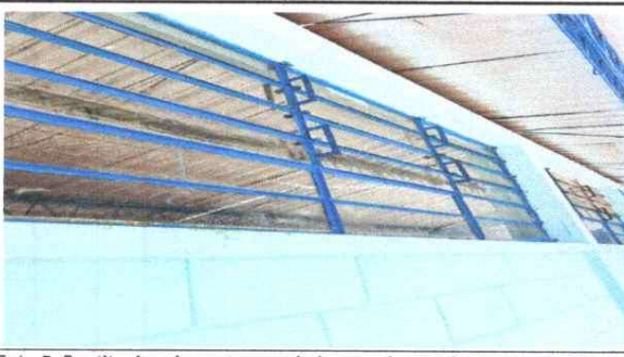
Foto 5: Sustitución de ventanas y balcones de metal
