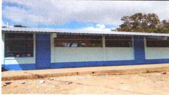
Foto 1: Sustitución de lamina por troquelada aluzinc calibre 26
