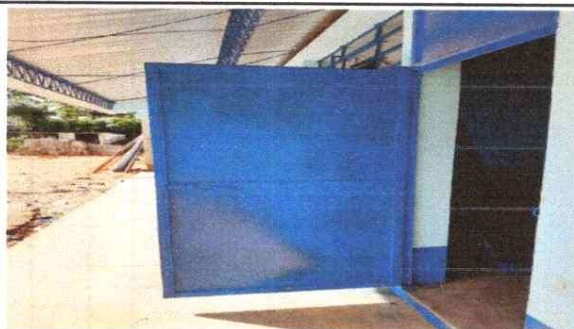
Foto 3: Sustitución de puertas de metal
