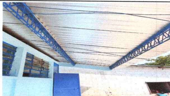
Foto 2: Sustitución de estructura de barilla por metal
