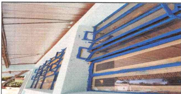
Foto 5: Sustitucion de ventanas y balcones de metal
