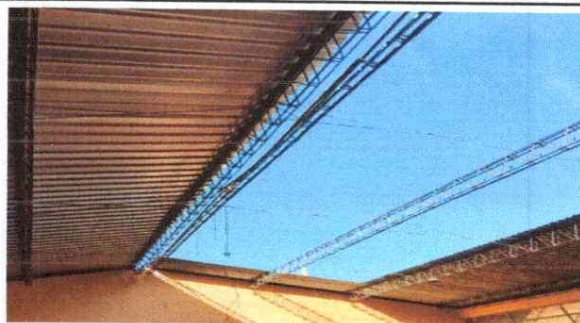
Foto 2: Sustitucion de estructura de barilla por metal
