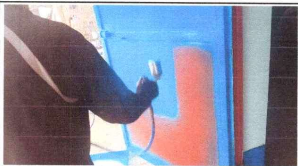
Foto 3: Sustitucion de puertas de metal
