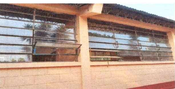
Foto 5: Sustitucion de ventanas y balcones de metal
