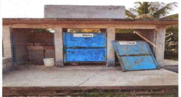
Foto 4: Mantenimiento a estructura (lijado, cambio de tubo, cepillado, aplicacion de pintura) a puerta de sanitario. Reparacion de torta de concreto.
