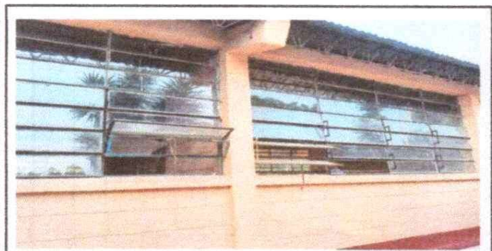
Foto 5: Sustitucion de ventanas y balcones de metal
