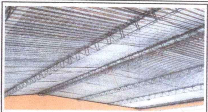
Foto 2: Sustitucion de estructura de barilla por metal
