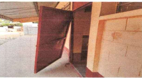
Foto 3: Sustitucion de puertas de metal
