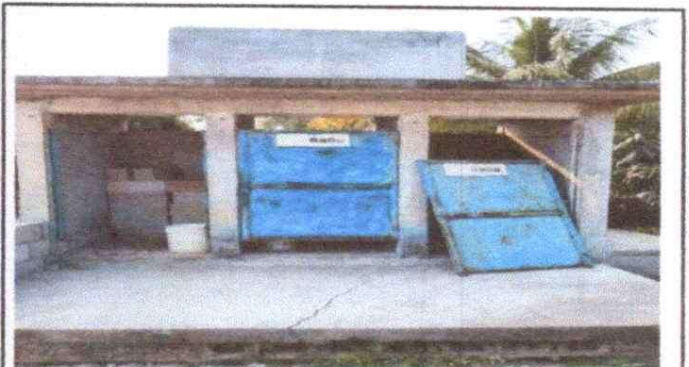
Foto 4: Mantenimiento a estructura (lijado,cambio de tubo, cepillado,aplicación de pintura) a puerta de sanitario. Reparacion de torta de concreto.
