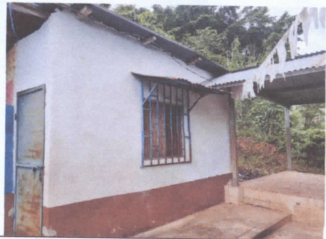
foto 6 sustitución de balcones de metal.
