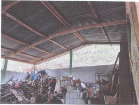
foto 3 Sustitución de estructura de madera por metálica.
