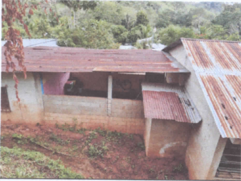
foto 1. Sustitución de lámina y estructura de madera a metal.
