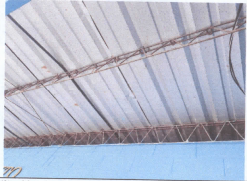
Foto 2 Sustitución de estructura metalica por metalica.
