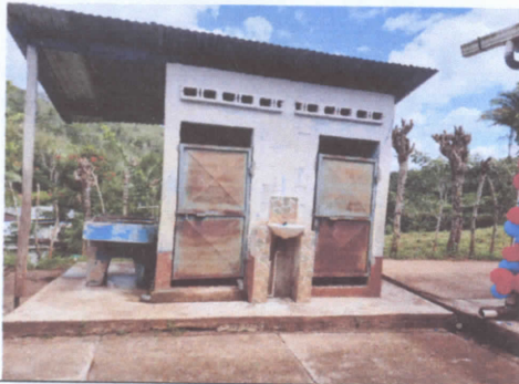
Foto 5 sustitución de 2 puertas metalicas de baño y sustituyó de 2 pilas de cemento de 2 lavaderos.
