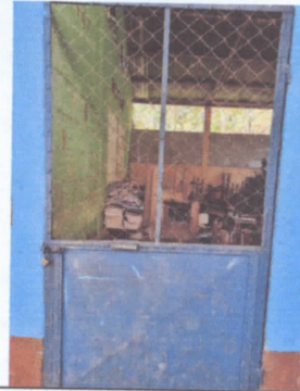
Foto 4 Sustitución de puerta de metal por metal.
