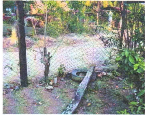
FOTO 2: REPARACION DE MURO PERIMETRAL
