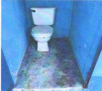
FOTO 1: REPARACION DE SERVICIOS SANITARIOS
