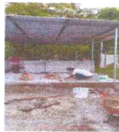
6. SUSTITUCION DE PISO CERAMICO
