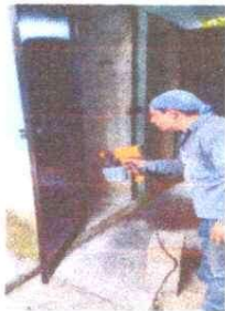
1. SUSTITUCION DE LAMINA POR LAMINA TROQUELADA ALUZINC CAL. 26
