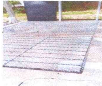
4. SUSTITUCION DE BALCONES DE METAL
