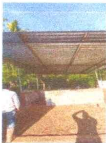
5. SUSTITUCION DE PISO DE TORTA DE CONCRETO
