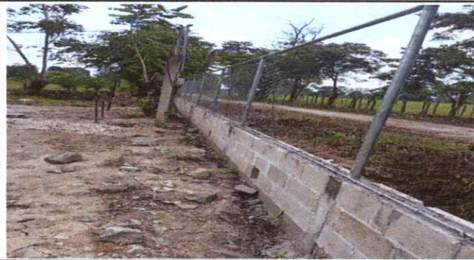
Foto 2: Reparacion de muro perimetral de block, tubo ag y malla
