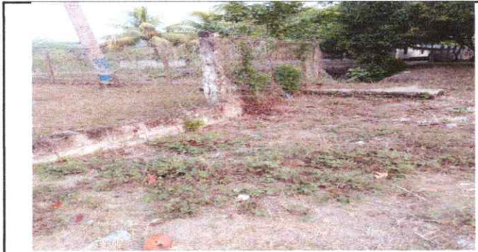
Foto 1: Reparacion de muro perimetral de block, tubo ag y malla
