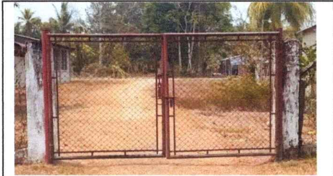
Foto 2: Mantenimiento a porton de metal
