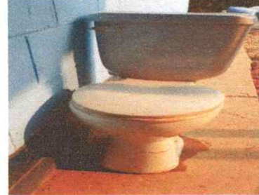
SUSTITUCIÓN DE INODORO
