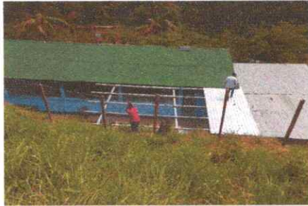
REPARACIÓN DE LA COCINA
