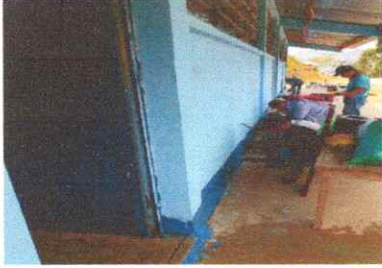
PINTURA EN MUROS EXTERIORES E INTERIORES
