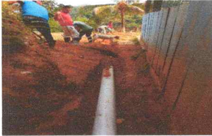
SUSTITUCION DE TUBERIA PVC AGUAS PLUVIALES
