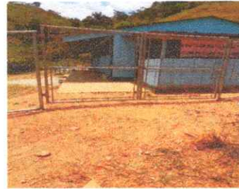
SUSTITUCIÓN DE PORTON
