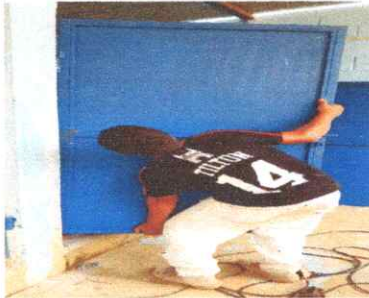
SUSTITUCIÓN DE PUERTA DE TRES BAÑOS Y UNA AULA
