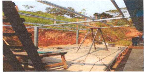
SUSTITUCIÓN DE ESTRUCTURA DE METAL POR MADERA
