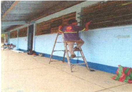
MANTENIMIENTO DE VENTANALES
