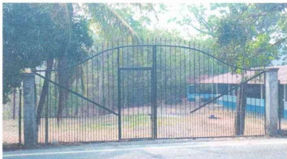
Foto 5: Mantenimiento a porton de metal
