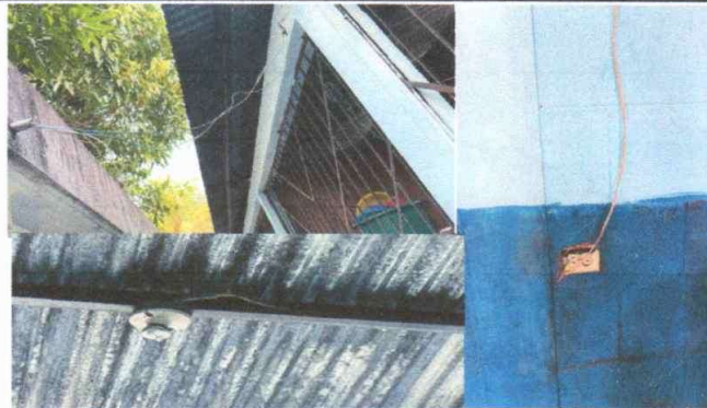
Foto 4: sustitución de focos ahorradores, sustitución de plafoneras, sustitución de tomacorrientes, cableado y ducto.
