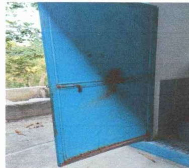
Foto 2: Mantenimiento a estructura (lijado, cambio de tubo , cepillado, sujeciones, aplicación de pintura)
