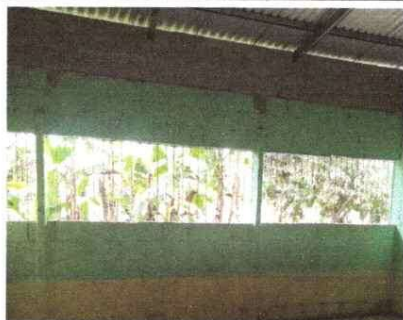
Foto 5: LEVANTAMIENTO DE ESTRUCTURA
