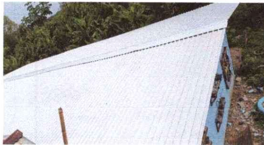
Foto 3: SUSTITUCION DE ESTRUCTURA DE TECHO
