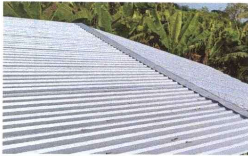
Foto 1: MANTENIMIENTO A TECHO
