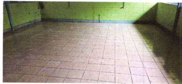
Foto 2: SUSTITUCION DE PISO POR PISO CERAMICO
