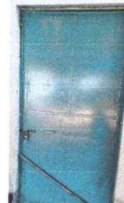
Foto 6: MANTENIMIENTO A PUERTAS DE METAL
