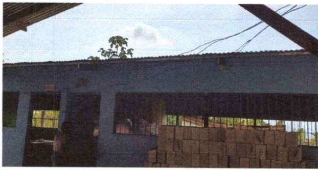
Foto 1: MANTENIMIENTO A TECHO
