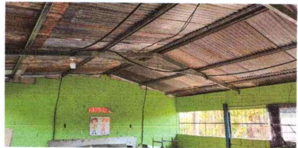
Foto 4: SUSTITUCION DE TECHO
