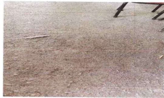
Foto 2: SUSTITUCION DE PISO POR PISO CERAMICO
