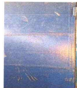
Foto 6: MANTENIMIENTO A PUERTAS DE METAL
