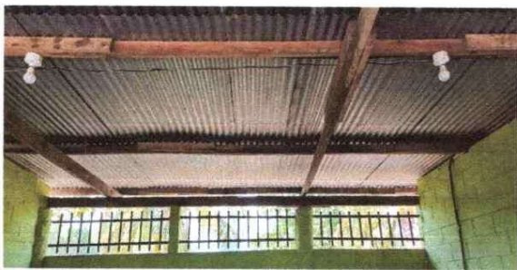
Foto 3: SUSTITUCION DE ESTRUCTURA DE TECHO
