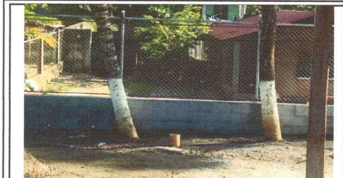
SEGUIMIENTO DE MURO PERIMETRAL
