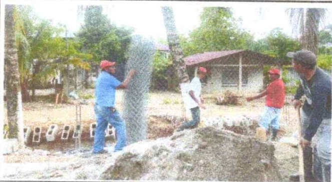
SEGUIMIENTO DE MURO PERIMETRAL
