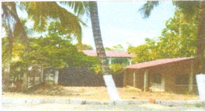
SEGUIMIENTO DE MURO PERIMETRAL
