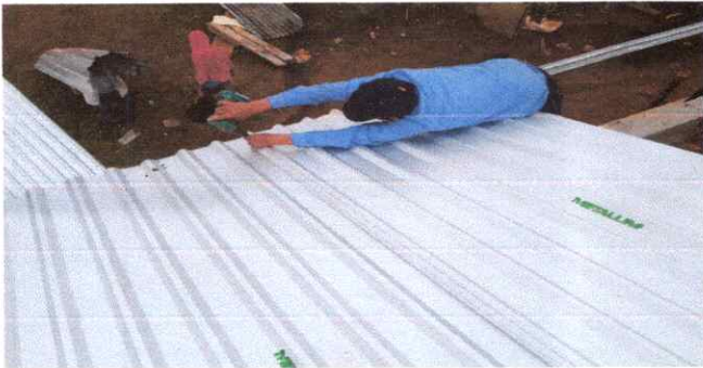
FOTO 3: INSTALACIÓN DE LAMINA TROQUELADA
