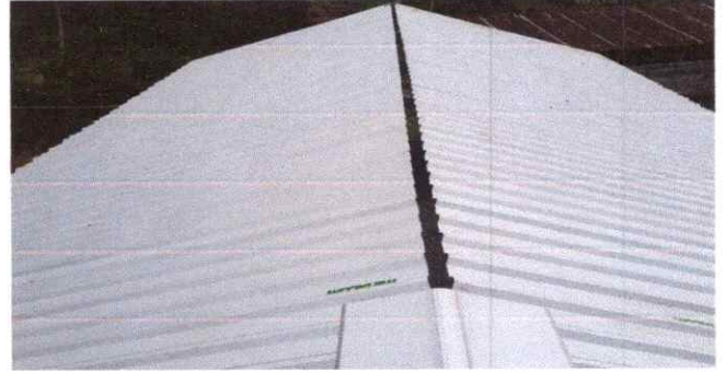
FOTO 4: INSTALACIÓN DE LAMINA TROQUELADA
