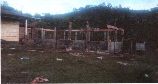
FOTO 1: LEVANTAMIENTO BASE CONCRETO
