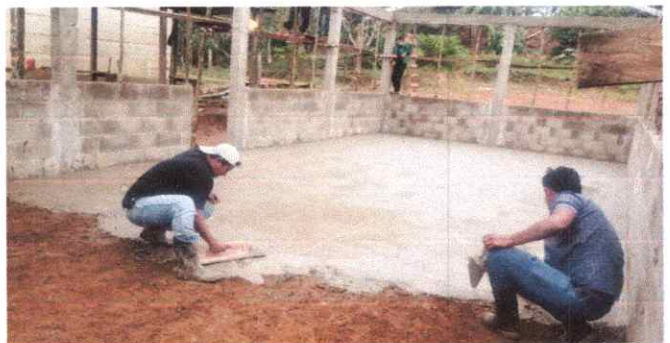
FOTO 6: SUSTITUCION DE PISO DE CONCRETO
