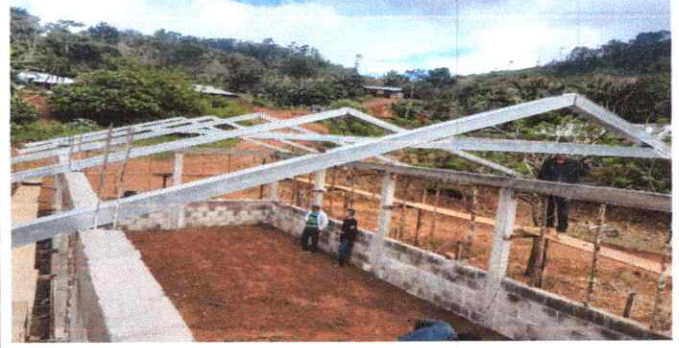
FOTO 2: INSTALACION DE ESTRUCTURAS METALICAS
