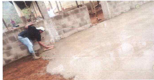
FOTO 5: SUSTITUCION DE PISO DE CONCRETO
