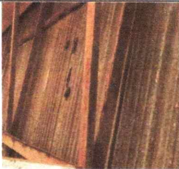
FOTO 1: SUSTITUCION DE LAMINA POR LAMINA TROQUEALDA
