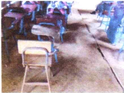
FOTO 3: REPARACION DE PISO TORTA
