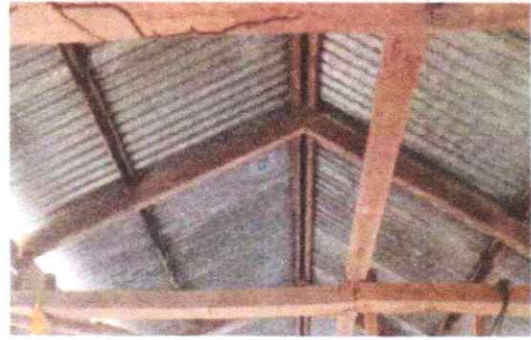
FOTO 2: SUSTITUCION DE ESTRUCTURA DE MADERA POR METAL
