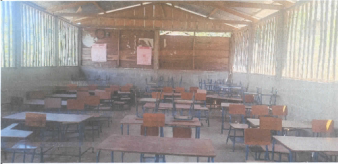
FOTO 1: Sustitucion de balcones de madera a metal y cambio de techo a estructura metalica
