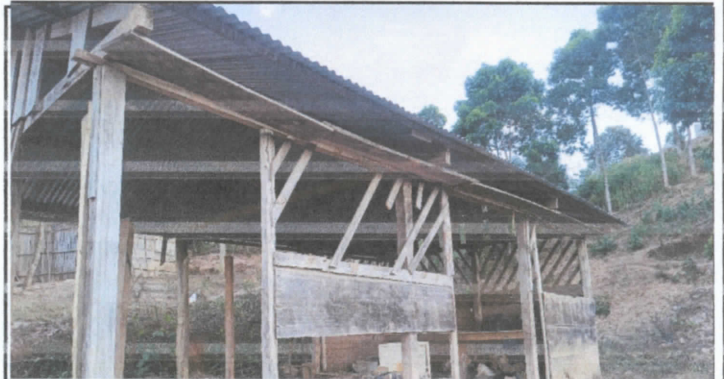
FOTO 4: Cambio de laminas y reparacion de cocina
