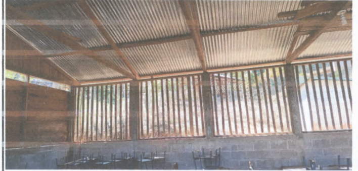
FOTO 2: Sustitucion de ventanas de madera a metal
