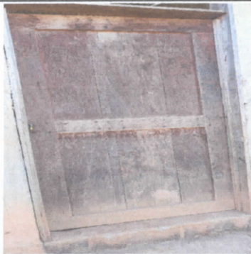
FOTO 5: Sustitucion de puerta de madera a puerta de metal.
