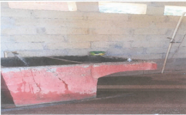
FOTO 3: Construcción de pila debido al mal estado
