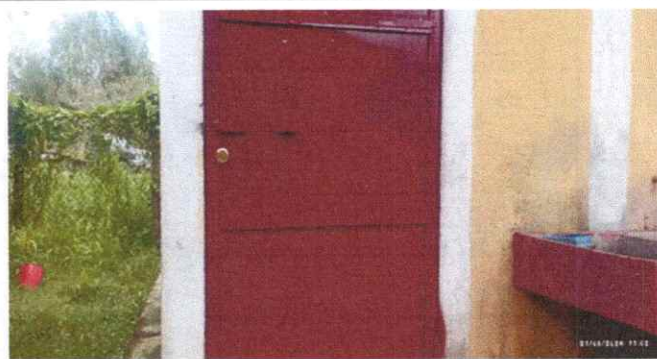
Foto 2. Sustitución de chapas.
