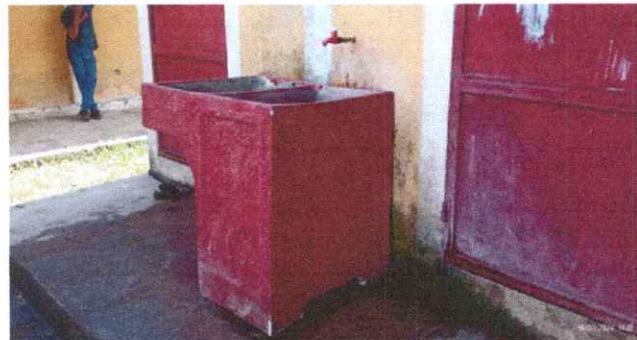
Foto 3. 2. Sustitucion de pila de concreto.
