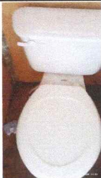
Foto 1. Sustitucion de tasa sanitaria.
