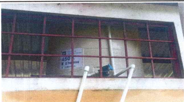
Foto 4. Sustitucion de deposito de agua.
