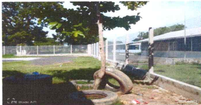
Foto 3. 3. 1. Sustitucion de block y malla.
