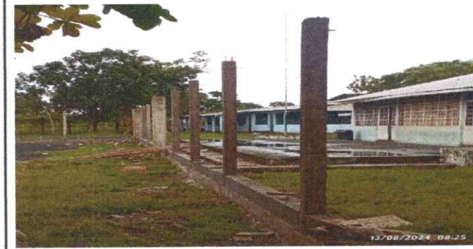
Foto 3. 3. 1. Sustitucion de block y malla.
