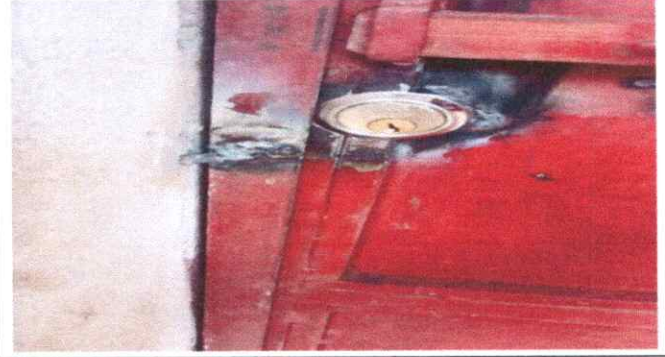
Foto 2. Sustitución de chapas.
