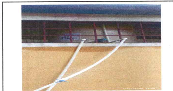
Foto 4. Sustitucion de deposito de agua.
