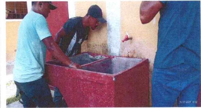
Foto 3. 2. Sustitucion de pila de concreto.
