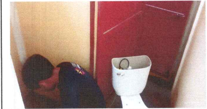
Foto 1. Sustitucion de tasa sanitaria.
