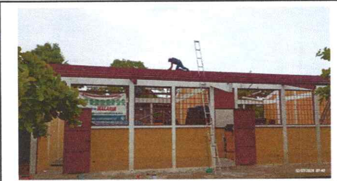
Foto 5. Sustitucion de lamina por lamina troquelada.
