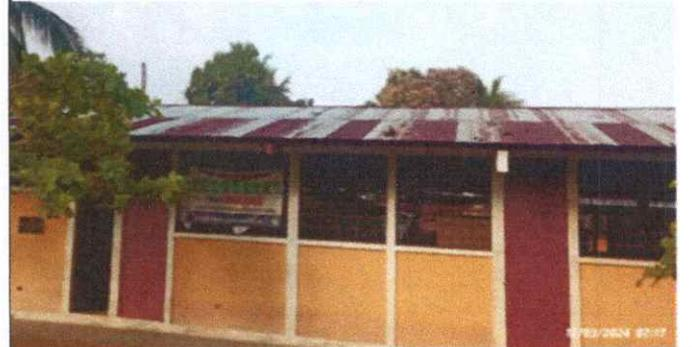
Foto 5. Sustitucion de lamina por lamina troquelada.
