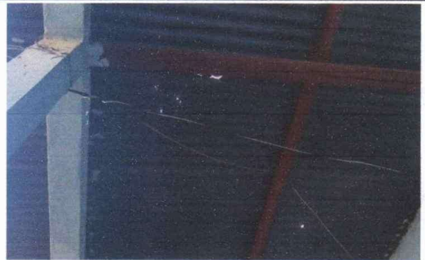
Foto 2: Sustitución de lámina por lámina troquelada calibre 26
