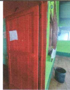
Foto 4: Sustitución de puerta de madera por puerta de metal
