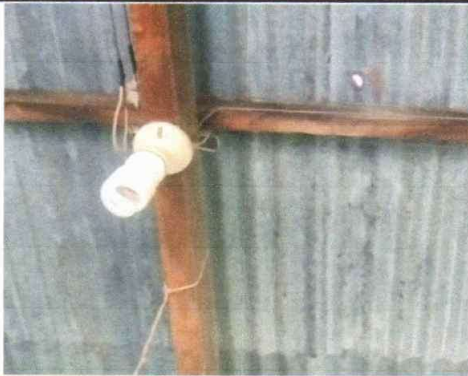
Foto 3: Sustitución de estructura de madera por metal
