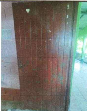
Foto 5: Sustitución de puerta de madera por puerta de metal
