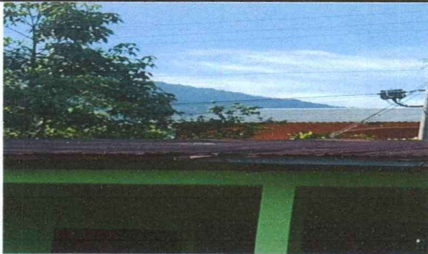
Foto 1: Sustitución de lámina por lámina troquelada calibre 26
