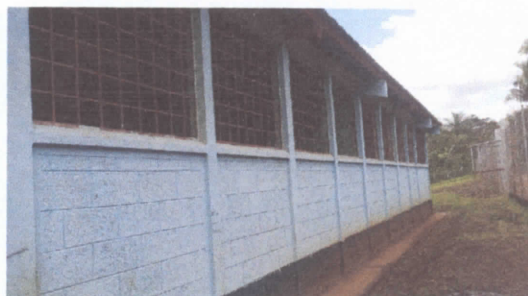
FOTO 6: SUSTITUCION DE BALCONES
