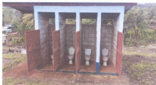
FOTO 4: SUSTITUCION DE PUERTA DE BAÑOS
