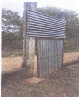
FOTO 5: SUSTITUCION DE PORTON DE METAL
