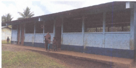
FOTO 7: PINTURA EN MUROS INTERIORES Y EXTERIORES
