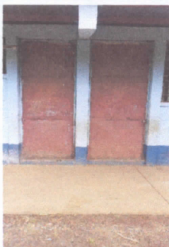
FOTO 3: SUSTITUCION DE PUERTAS DE AULA
