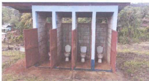
FOTO 2: SUSTITUCION DE LAMINA DE BAÑOS
