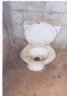
FOTO 8: SUSTITUCION DE INODORO
