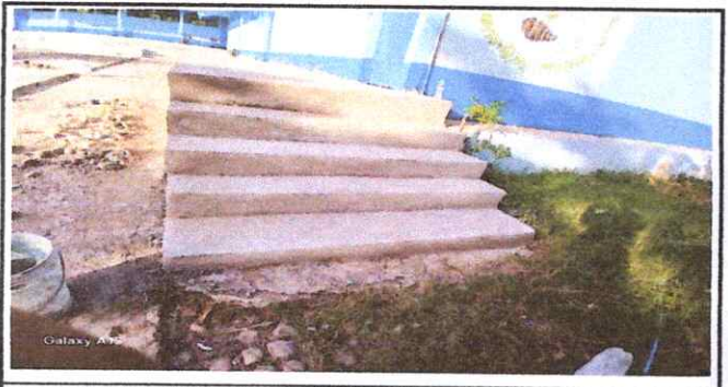
Foto 5: REPARACION DE PISO TORTA DE CONCRETO
