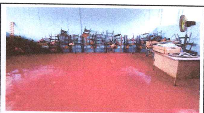
Foto 4: SUSTITUCION DE PISO DE CONCRETO
