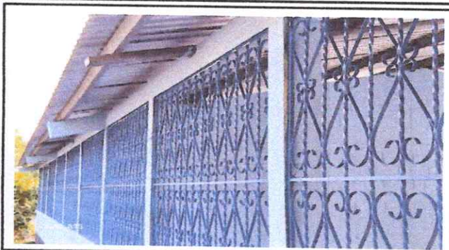
Foto 2: MANTENIMIENTO A BALCONES DE METAL
