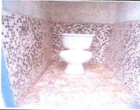
Foto7: sustitucion de inodoro
