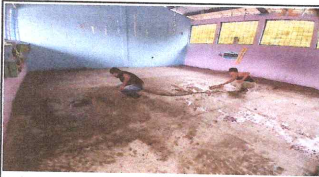
Foto 3: SUSTITUCION DE PISO DE CONCRETO
