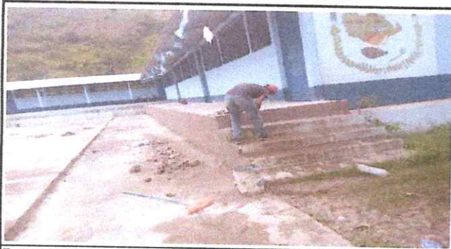
Foto 5: REPARACION DE PISO TORTA DE CONCRETO
