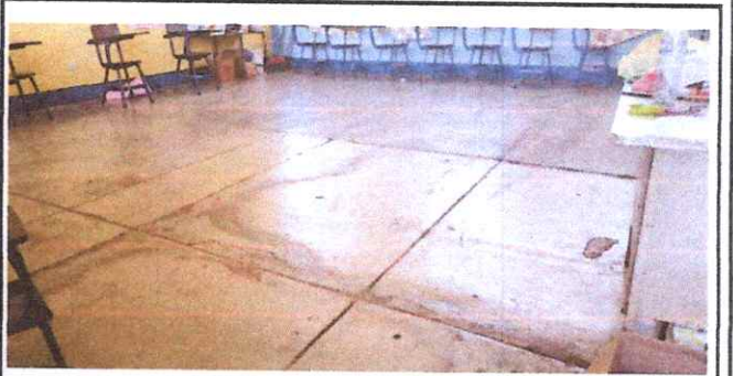
Foto 4: SUSTITUCION DE PISO DE CONCRETO
