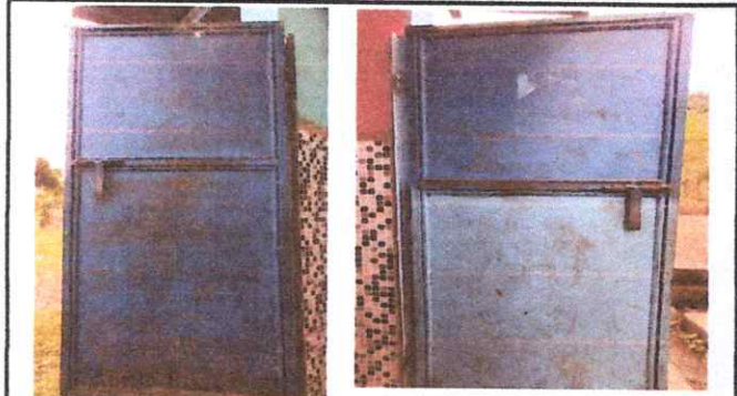
Foto1: MANTENIMIENTO PUERTAS DE METAL
