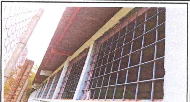
Foto 2: MANTENIMIENTO A BALCONES DE METAL
