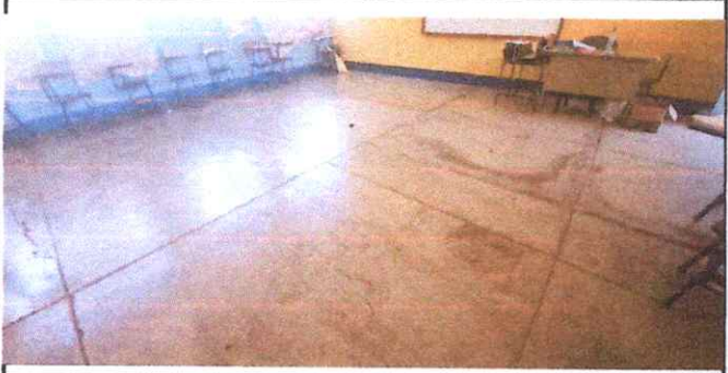
Foto 3: SUSTITUCION DE PISO DE CONCRETO
