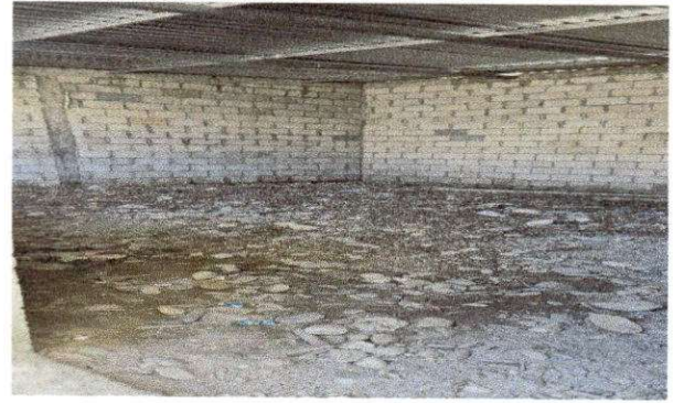
Foto 8: REMOZAMIENTO DE AULA SUMINIISTRO E INSTALACION DE SISTEMA ELECTRICO ILUMINACION
