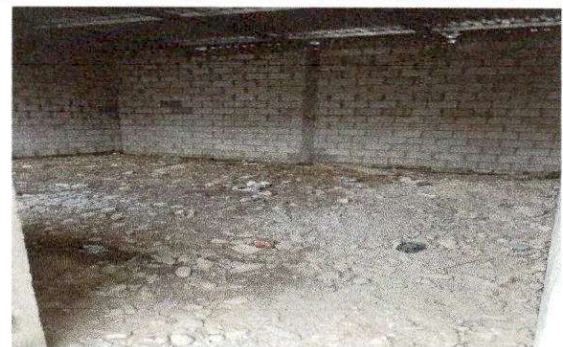
Foto 6: REMOZAMIENTO DE AULA SUMINIISTRO E INSTALACION DE SISTEMA ELECTRICO ILUMINACION
