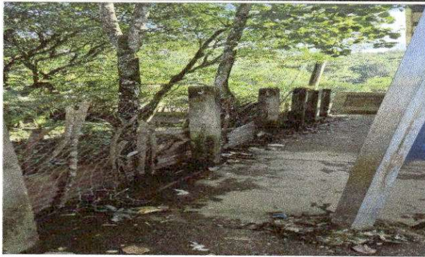
Foto 9: MURO PERIMETRAL CON REFUERZO ESTRUCTURAL-
