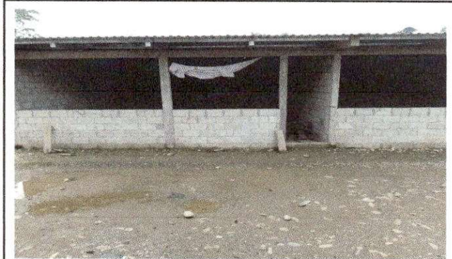
Foto 4: REMOZAMIENTO DE AULA
