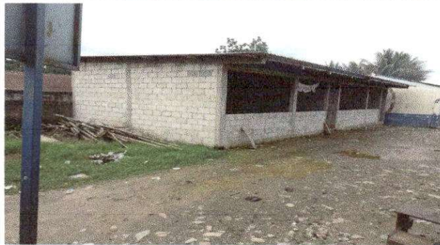
Foto 3: REMOZAMIENTO DE AULAS
