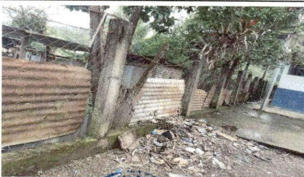
Foto 11: AMPLIACION MURO EN AULA CON REFUERZO ESTRUCTURAL
