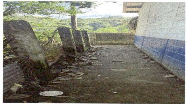
Foto 10: AMPLIACION MURO EN AULA CON REFUERZO ESTRUCTURAL
