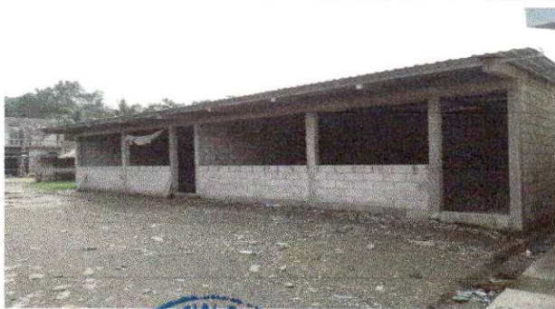
Foto 5: REMOZAMIENTO DE AULA SUMINIISTRO E INSTALACION DE SISTEMA ELECTRICO ILUMINACION
