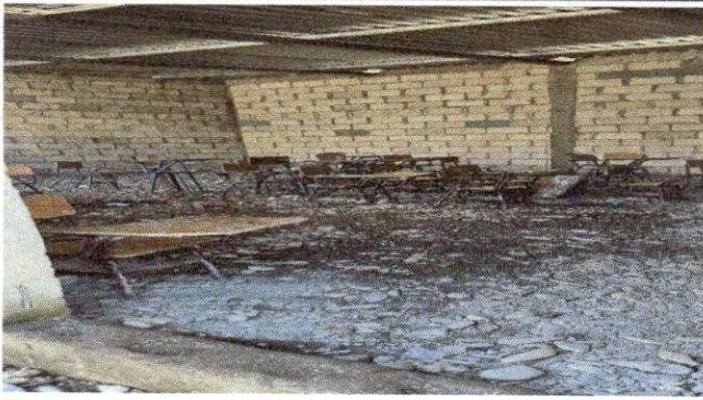
Foto 7: . REMOZAMIENTO DE AULA SUMINIISTRO E INSTALACION DE SISTEMA ELECTRICO FUERZA
