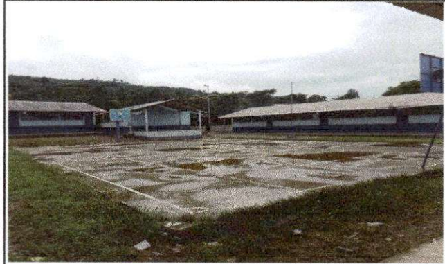
Foto 2: REMOZAMIENTO DE AULAS
