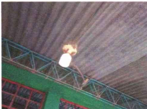
Foto 5: Reparación de cableado electrico
