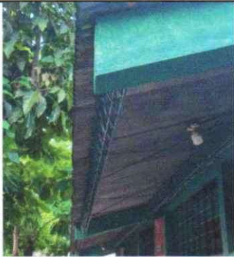
Foto 3: Sustitución de canal de pvc
