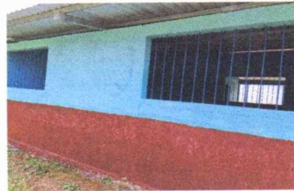
Foto 4: Sustitución de balcones de metal
