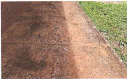
Foto 3: Sustitución de piso de torta de concreto
