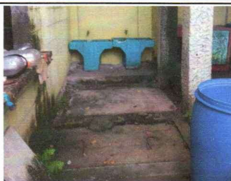
Foto 2: Reparación de tapaderas de cajas
