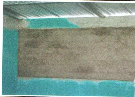
Foto 4: Sellado de paredes
