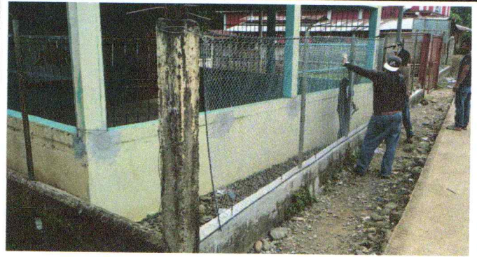
Foto 2: reparacion de muro perimetral
