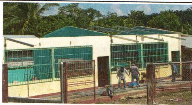
Foto 5: sustitucion de estructura de madera por metal y lamina troquelada.
