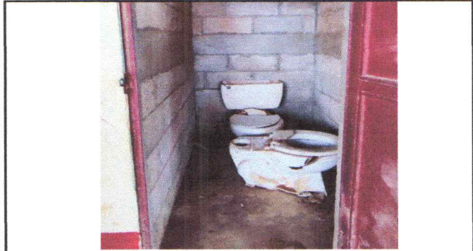
FOTO 1: SUSTITUCION DE SANITARIO
