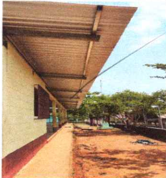
FOTO 5: SUSTITUCION DE LAMINA POR LAMINA TROQUELADA CALIBRE 26
