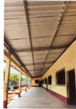
FOTO 4: SUSTITUCION DE LAMINA POR LAMINA TROQUELADA CALIBRE 26
