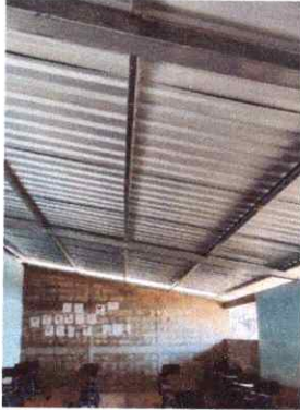
FOTO 1: SUSTITUCION DE ESTRUCTURA DE MADERA POR METAL
