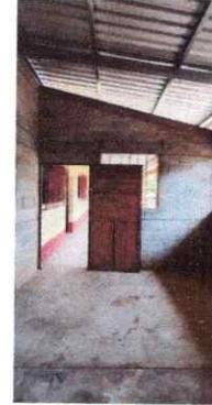
FOTO 2: SUSTITUCION DE ESTRUCTURA DE MADERA POR METAL
