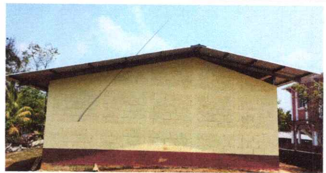
FOTO 6: SUSTITUCION DE LAMINA POR LAMINA TROQUELADA CALIBRE 26
