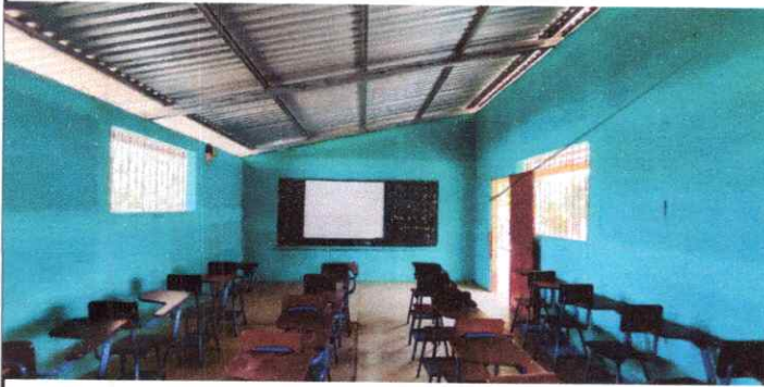
FOTO 3: SUSTITUCION DE ESTRUCTURA DE MADERA POR METAL
