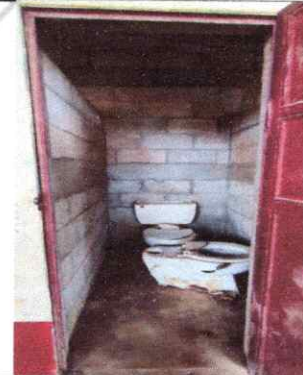
FOTO 6: SUSTITUCION DE SERVICIOS SANITARIOS
