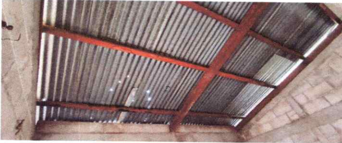
FOTO 1: SUSTITUCION DE LAMINA POR LAMINA TROQUELADA
