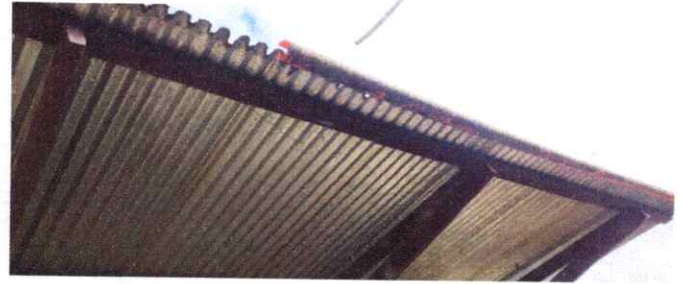
FOTO 2: SUSTITUCION DE LAMINA POR LAMINA TROQUELADA
