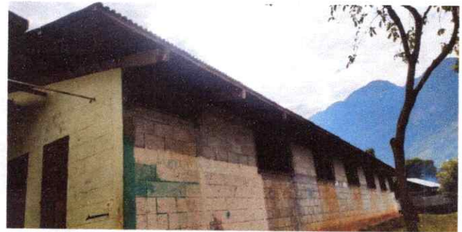
FOTO 4: SUSTITUCION DE ESTRUCTURA DE MADERA POR METAL
