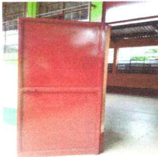
Foto 3: FINALIZACIÓN DE MANTENIMIENTO A PUERTAS DE METAL
