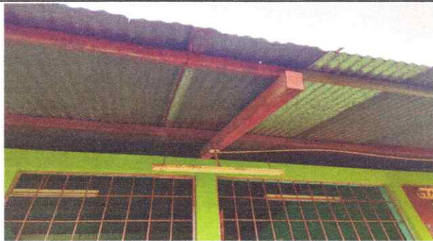
Foto1: SUSTITUCION DE LAMINA POR LAMINA TROQUELADA
