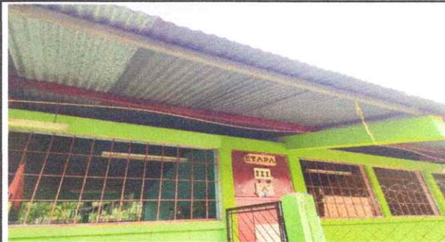
Foto 2: SUSTITUCION DE ESTRUCTURA DE METAL EN MAL ESTADO
