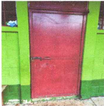
Foto 3: MANTENIMIENTO A PUERTAS DE METAL
