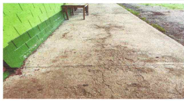
Foto 4: REPARACION DE PISO DE TORTA
