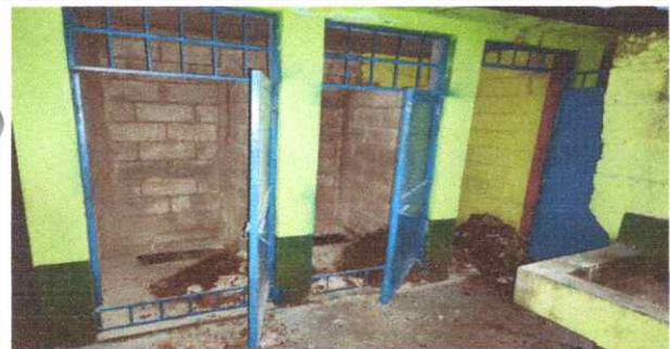
Foto 5: REPARACIÓN E INSTALACIÓN DE BAÑOS
