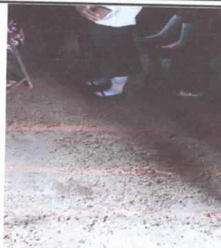
FOTO 2: Sustrucion de piso de concreto
