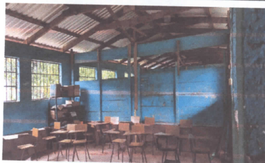
FOTO 4: Reparacion y mantenimiento de paredes
