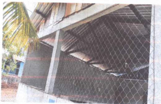
FOTO 5: Sustrucion baranda por metal
