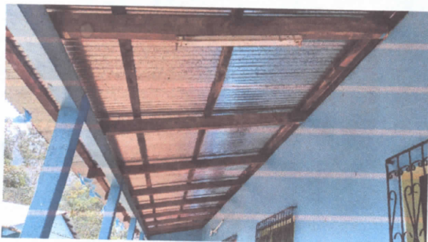
FOTO 3: Sustrucion de sistema electrico
