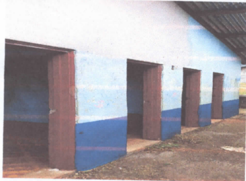
FOTO 1: Sustrucion de puertas de servicios sanitarios
