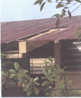
FOTO 1: SUSTITUCION DE LAMINA POR LAMINA TROQUELADA
