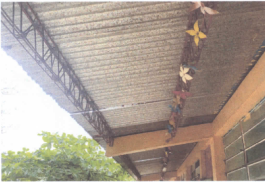
FOTO 3: MANTEMIENTO A ESTRUCTURA DE METAL
