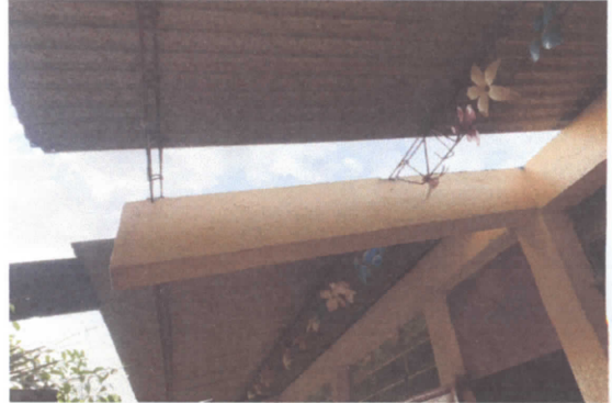
FOTO 2: SUSTITUCION DE LAMINA POR LAMINA TROQUELADA
