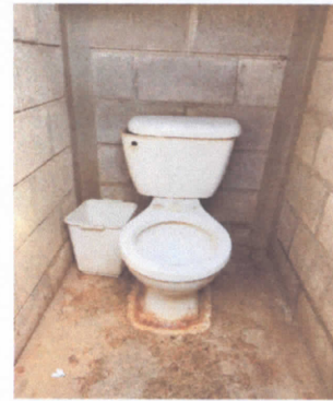
FOTO 4: SUSTITUCION DE SERVICIOS SANITARIOS
