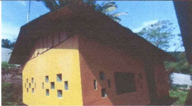
SUSTITUCIÓN DE LÁMINA POR LÁMINA TROQUELADA ALUZINC CALIBRE 26 Y ESTRUCTURA DE MADERA POR METAL DE COCINA.
