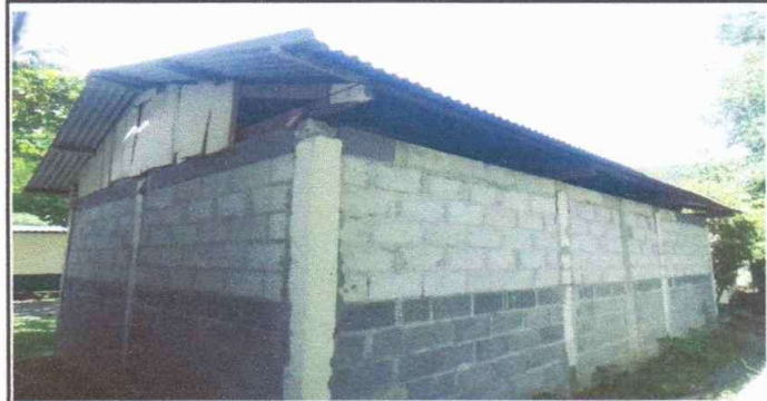
REPELLO EN MURO DE BODEGA.
