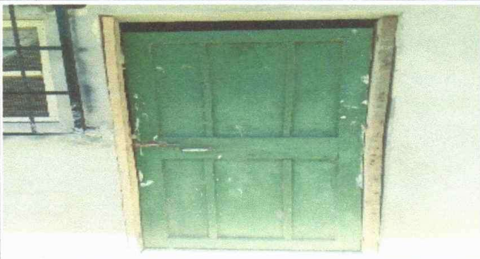
SUSTITUCIÓN DE (2) PUERTAS DE MADERA POR METAL DE BODEGA.
