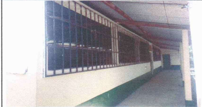
MANTENIMIENTO A BALCONES DE METAL
