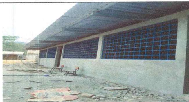
FOTO 5: REPELLO EXTERIOR E INTERIOR DE DOS AULAS.
