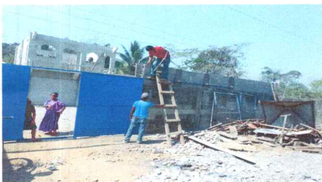
FOTO 3: FABRICACIÓN E INSTALACION DEL PORTON CORREDIZOS
