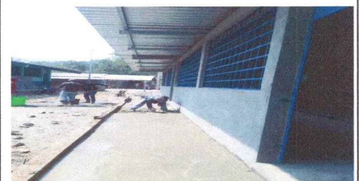
FOTO 6: REMODELACIÓN DE PISO DEL CORREDOR.
