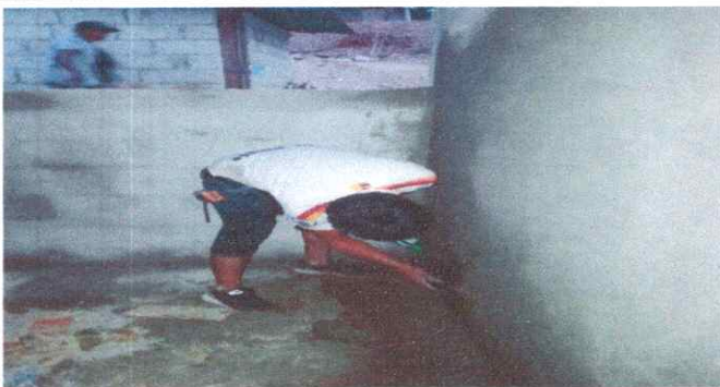
FOTO 5: REPELLO EXTERIOR E INTERIOR DE DOS AULAS.
