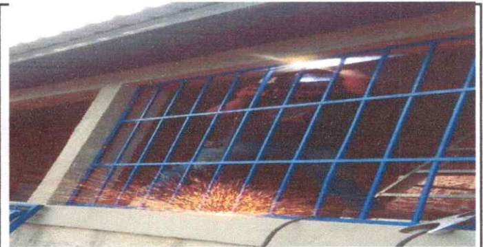
FOTO 4: FABRICACIÓN E INSTALACIÓN DE BALCONES.
