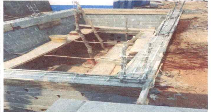
FOTO 2: LEVANTAMIENTO DE MURO DEL SERVICIO SANITARIO.
