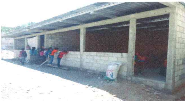
FOTO 5: REPELLO DE MURO DE PARED DE DOS AULAS.
