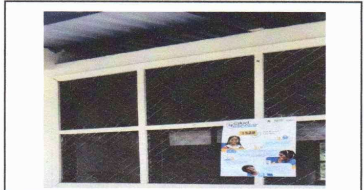
Foto 2: sustitución de estructura de madera por metal en ventanas
