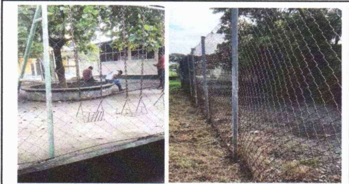
Foto 3: Reparación de muro perimetral
