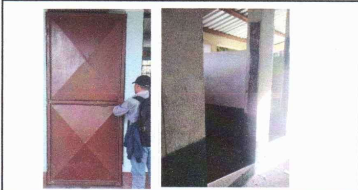
Foto1: Sustitución de puerta de metal de aulas y sanitarios
