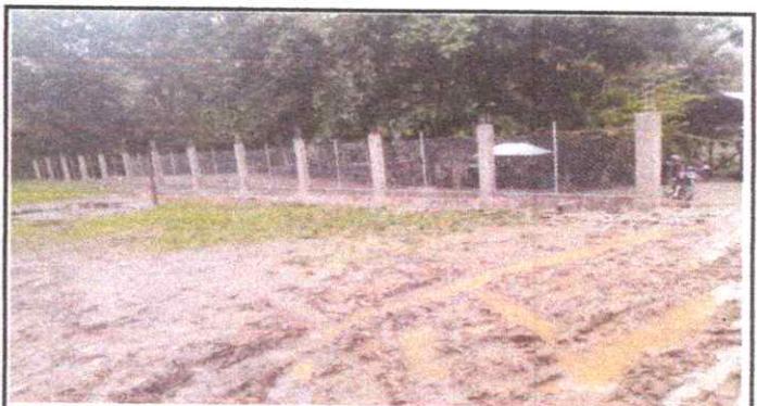
FOTO 4. REPARACIÓN DE MURO PERIMETRAL.
