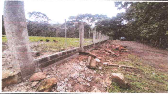
FOTO 1. REPARACIÓN DE MURO PERIMETRAL.
