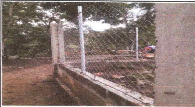
FOTO 3. REPARACIÓN DE MURO PERIMETRAL.
