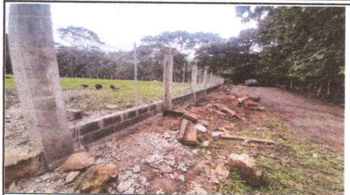
FOTO 2. REPARACIÓN DE MURO PERIMETRAL.
