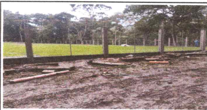
FOTO 5. REPARACIÓN DE MURO PERIMETRAL.
