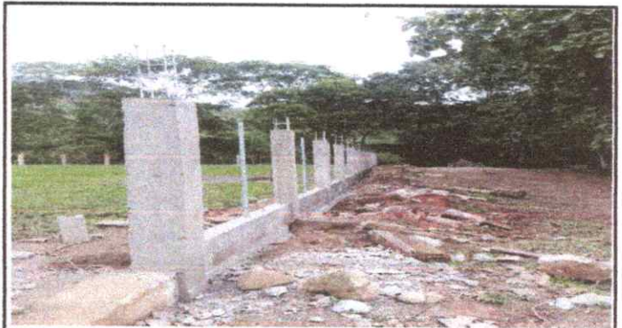
FOTO 4. REPARACIÓN DE MURO PERIMETRAL.
