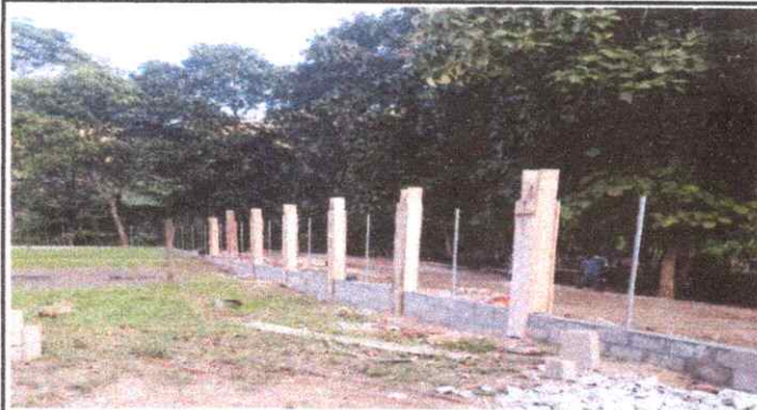
FOTO 3. REPARACIÓN DE MURO PERIMETRAL.
