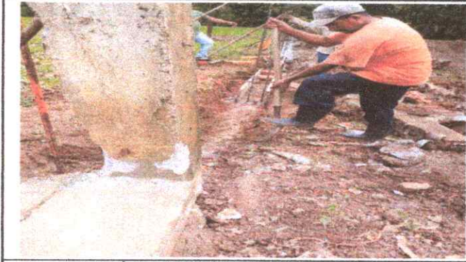
FOTO. REPARACIÓN DE MURO PERIMETRAL.
