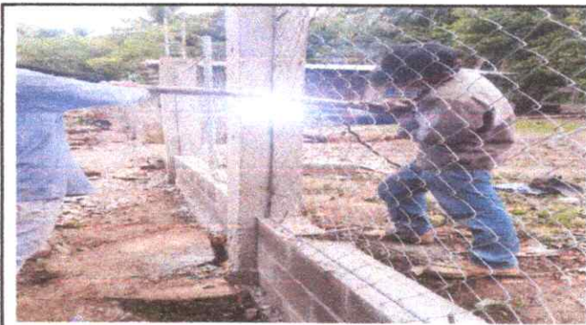
FOTO 5. REPARACIÓN DE MURO PERIMETRAL.
