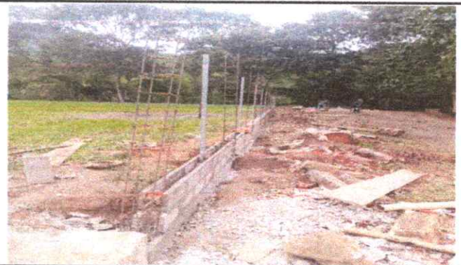
FOTO 2. REPARACIÓN DE MURO PERIMETRAL.
